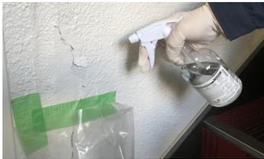
採取箇所を刷毛でほこりや汚れをきれいに落とし、大きめのビニール袋で採取箇所を囲うように養生する。粉じんが飛散しないように採取面を霧吹きで湿潤化する。
