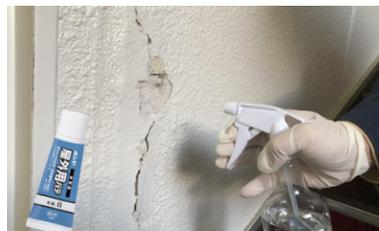
最後に、採取箇所に飛散防止用固化剤等で処置を施し、地面や床の粉じん等もウエットティッシュや刷毛、掃除機等でキレイにする。
